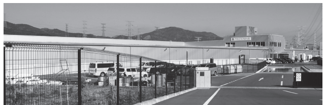
PSG棟の2階部分は事務室。両棟の傍には、チラーユニット、サイロ、非常用の液体酸素カートリッジや自家発電機などがある。
